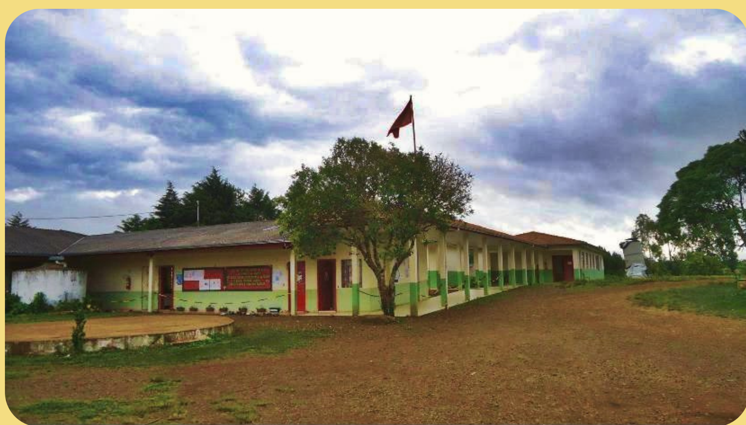
Escola do Campo Vinte e Cinco de Maio, Fraiburgo. Fonte: Arquivo da escola.
