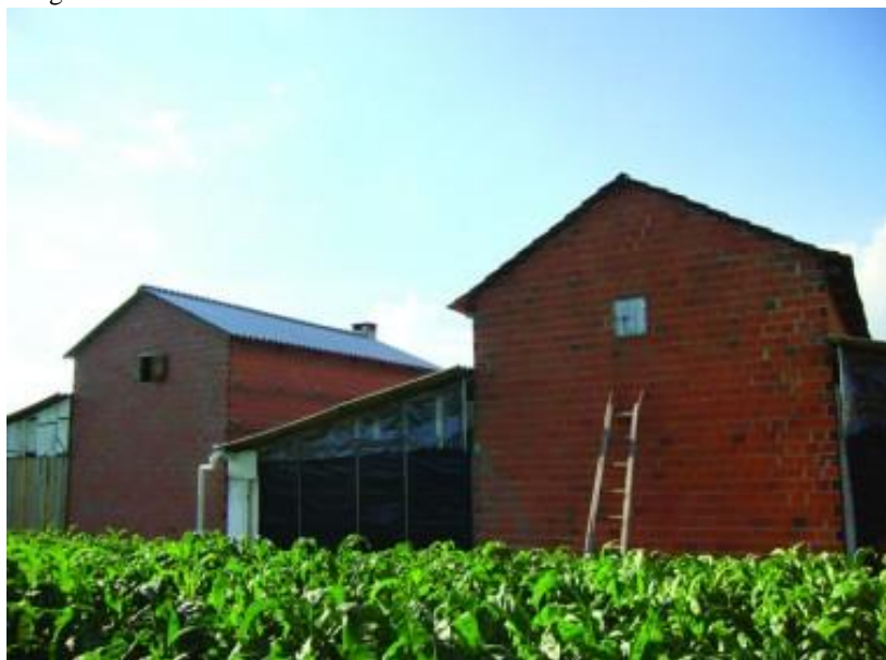
Imagem 7 - Estufa Convencional – taco – estrutura externa
