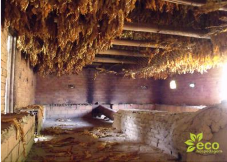
Imagem 8 - Estufa Convencional – taco – estrutura interna
